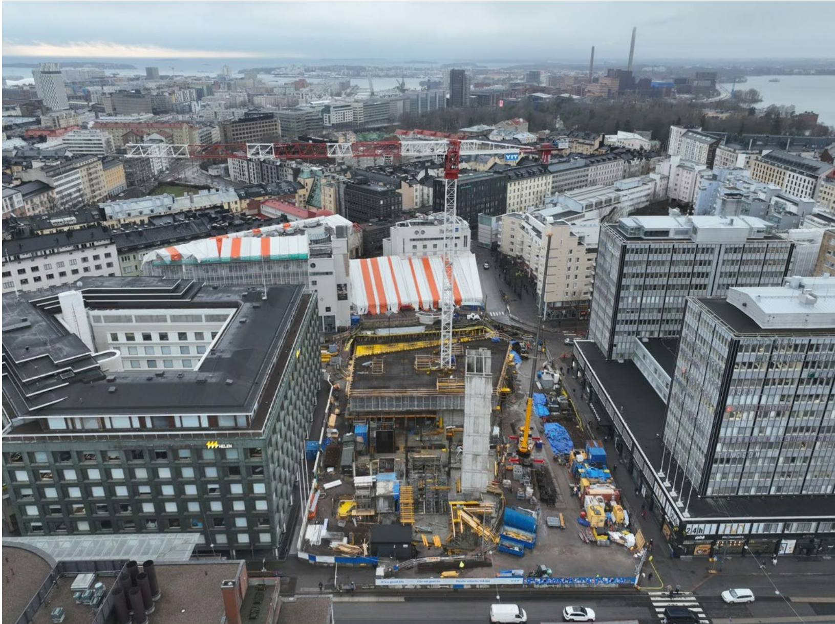
Droonikuva työmaasta kohti Radisson Blu hotellin korjaustyömaata 29.10.2024
